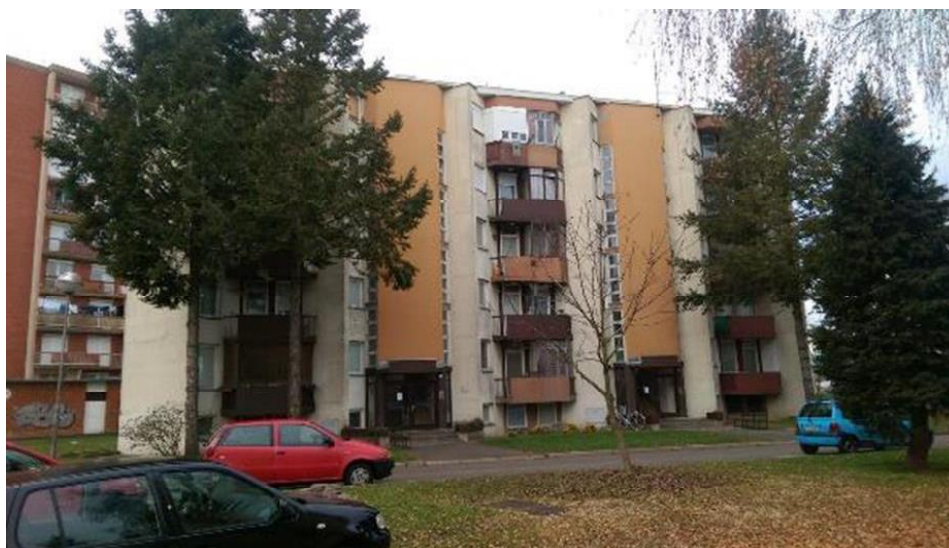
Slika 2. Istočno pročelje zgrade
