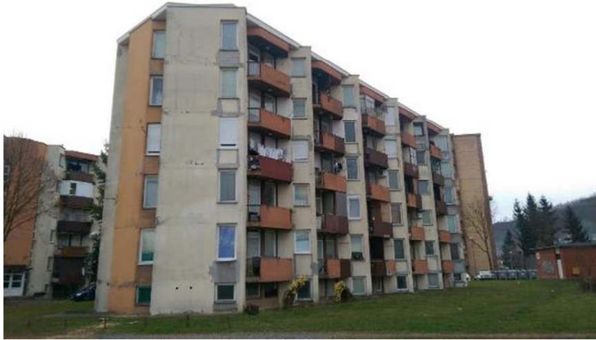
Slika 4. Zapadno pročelje zgrade
